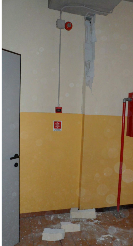
Distacco di intonaco
