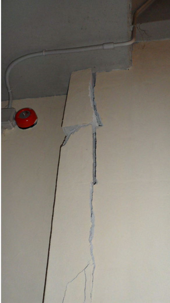
Distacco di intonaco
